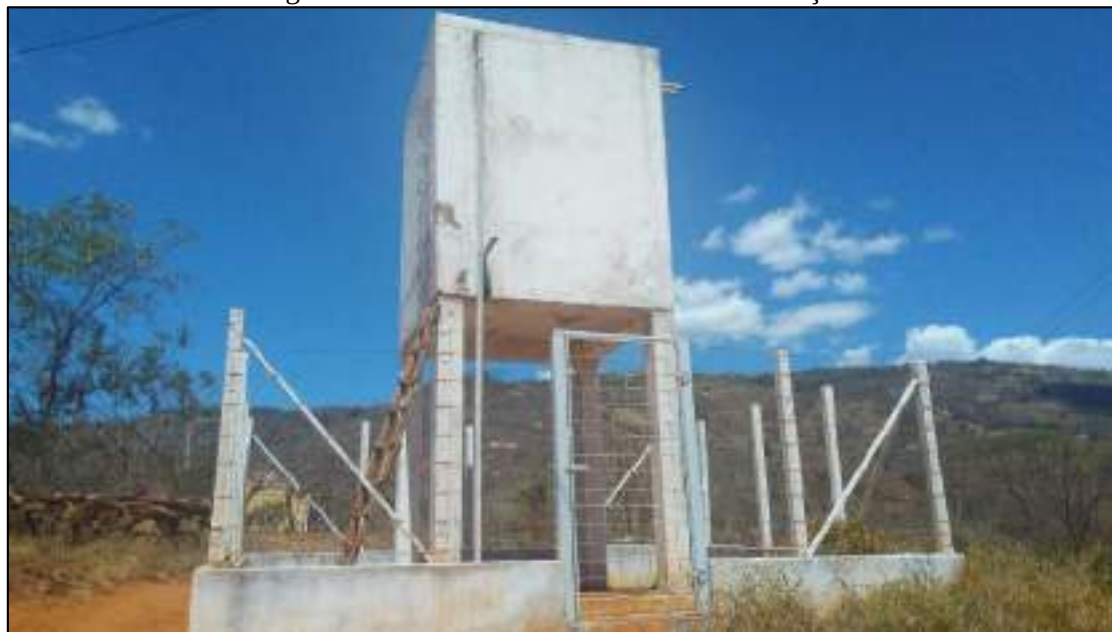
Figura 29 – Reservatório I – Sítio Saco dos Caçulas
