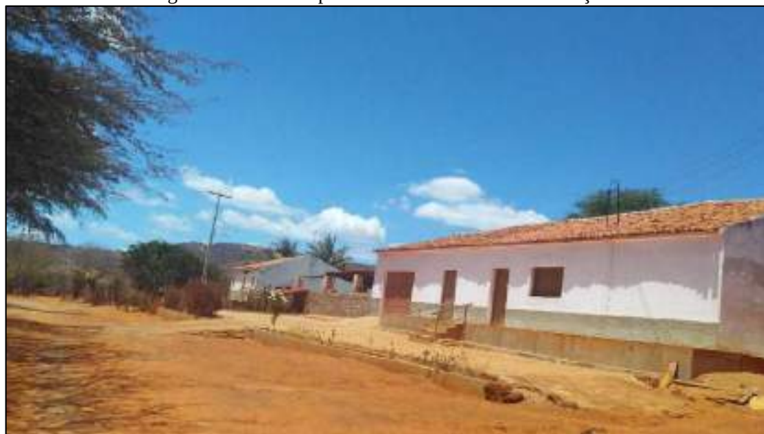
Figura 85 - Rua não pavimentada - Sítio Saco dos Caçulos
