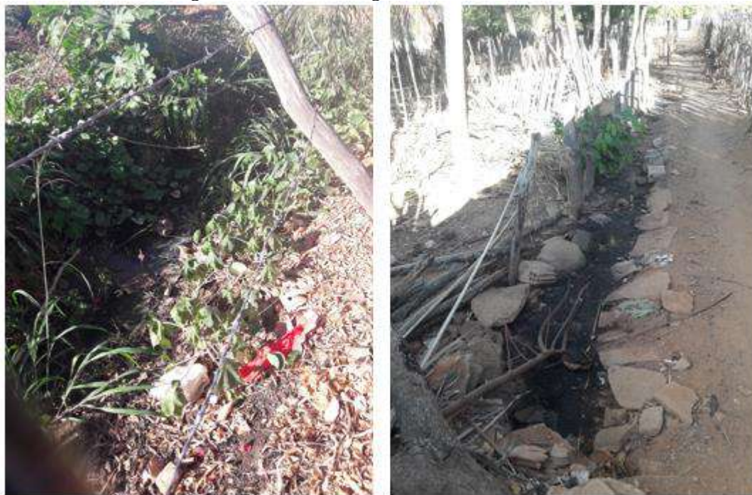
Figura 70 - Ponto de Esgoto no Bairro Santa Rosa
