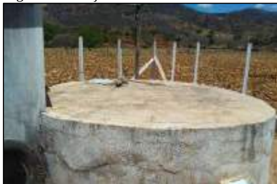
Figura 27 – Poço amazônico II – visão frontal
