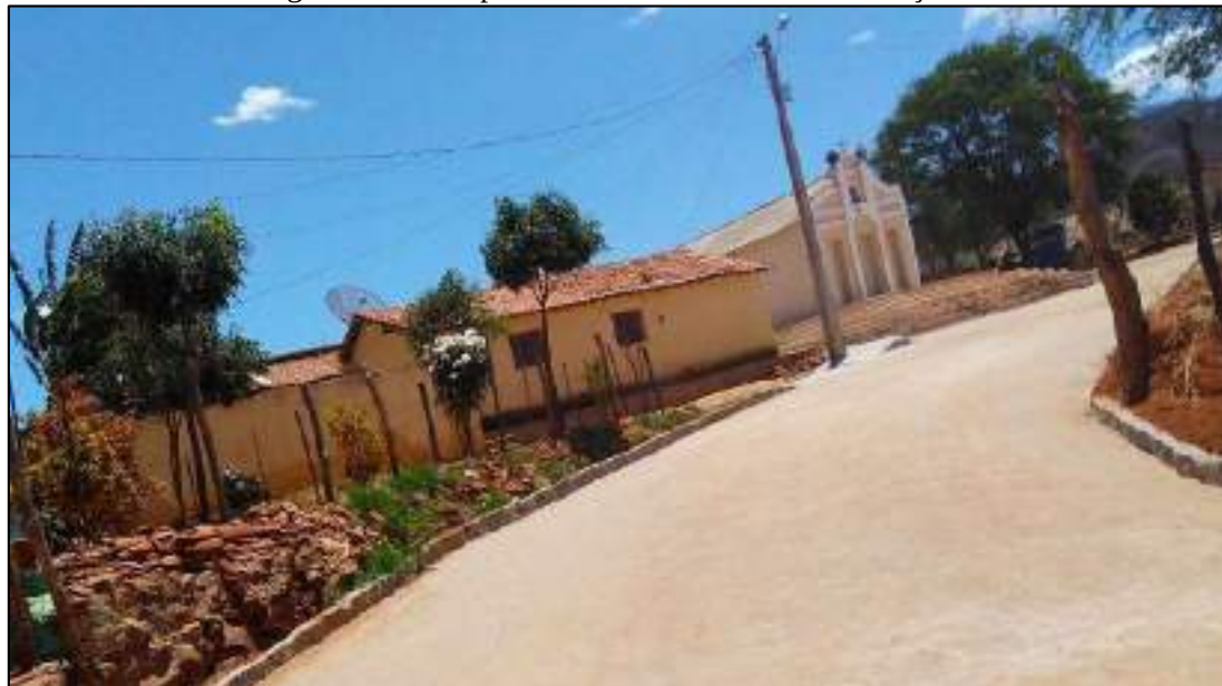
Figura 84 – Rua pavimentada – Sítio Saco dos Caçulos
