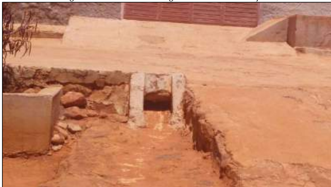
Figura 86 – Estrutura de drenagem – Sítio Saco dos Caçulos
