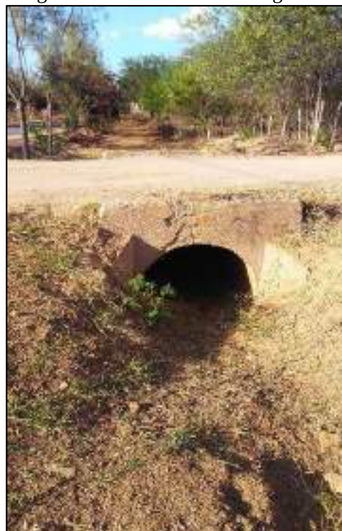
Figura 97 – Estrutura de drenagem III
