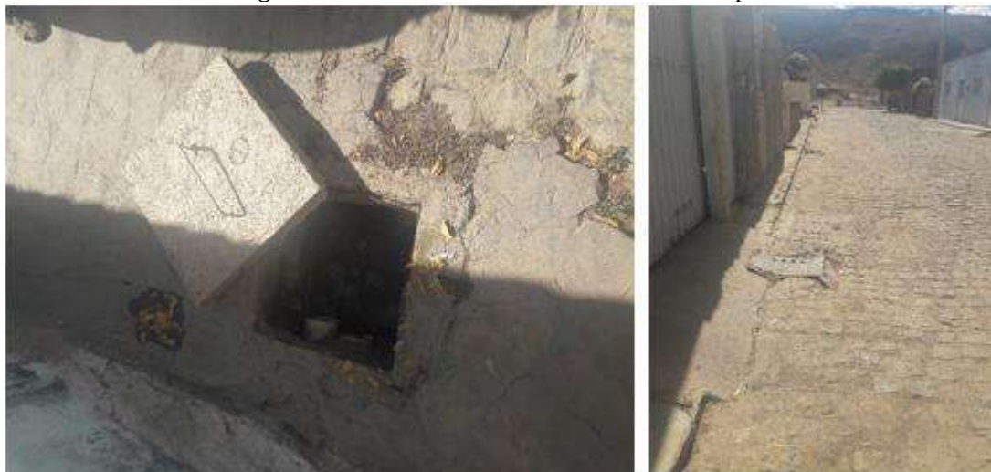
Figura 66 - Rua com Rede Coletora no Município
