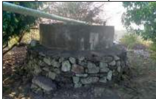
Figura 53 – Cisterna de placa II
