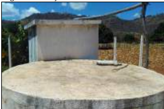
Figura 28 – Poço amazônico II – visão lateral
