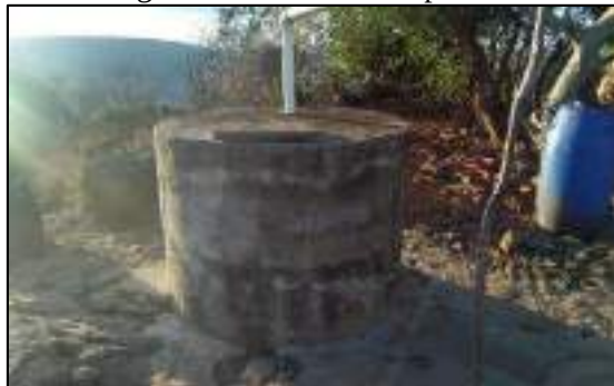
Figura 52 – Cisterna de placa I
