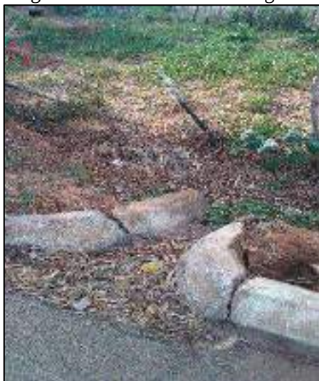
Figura 74 - Estrutura de drenagem I
