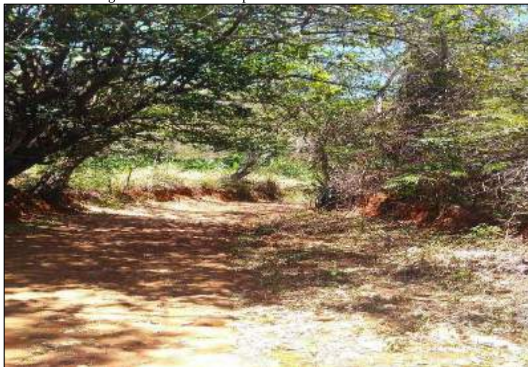
Figura 87 - Estradas não pavimentadas – Sítio Piancozinho
